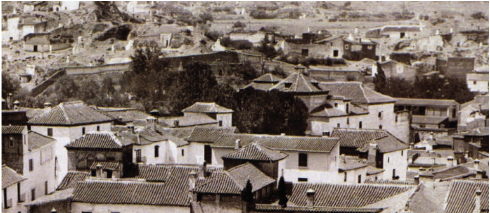
Lám. 8. Vista panorámica del convento de Santo Domingo de Guadix, con la huerta anexa, y restos del claustro (ca. 1900). Fuente: Archivo particular.
