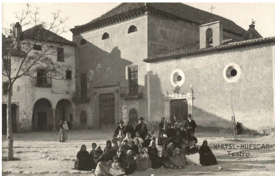
Lám. 2. Fachada principal del convento e iglesia de Santo Domingo de Huéscar. A la derecha, la capilla del Rosario. Fuente: Archivo Histórico Municipal de Huéscar.
