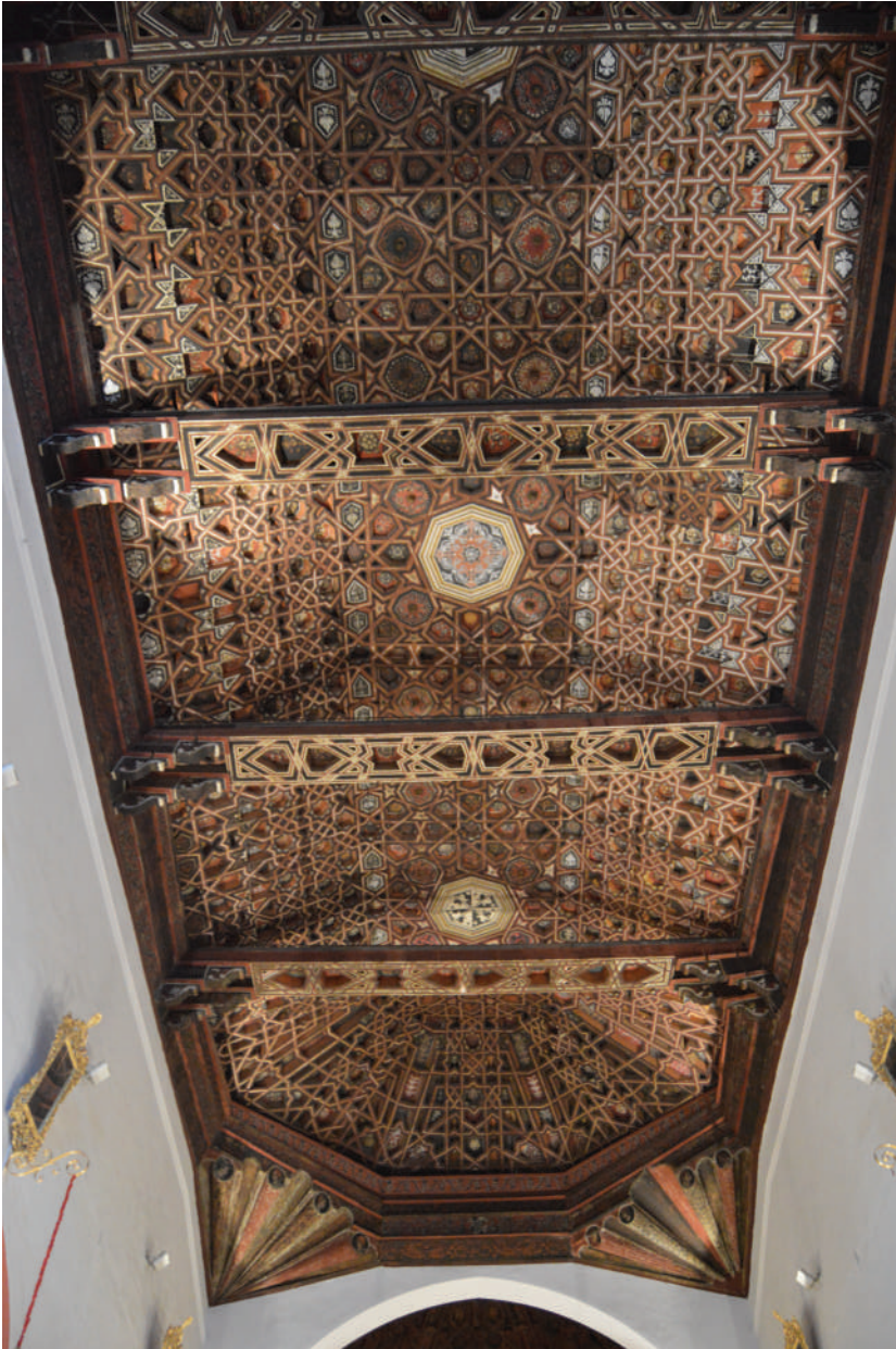
Lám. 7. Armadura de la nave central de la antigua iglesia de Santo Domingo de Guadix. Foto del autor.
