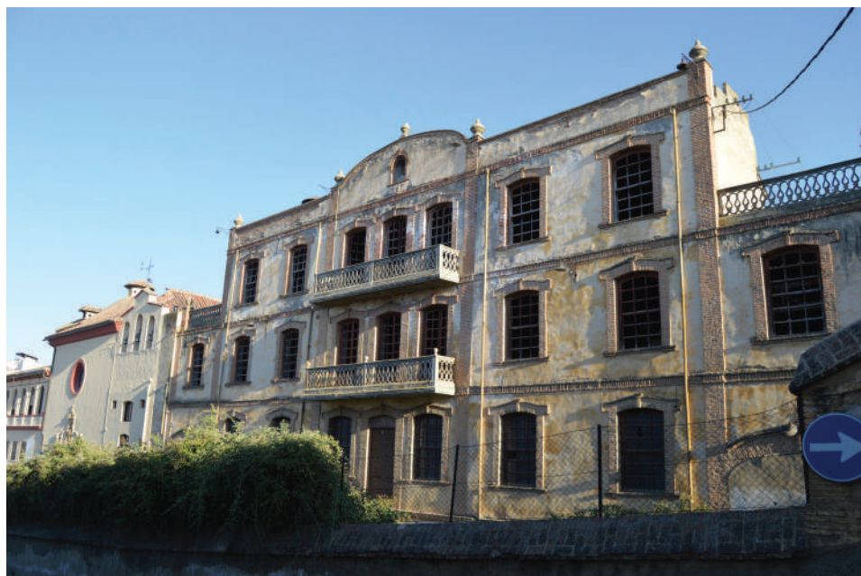
Lám. 9. Fábrica de harinas levantada en 1930, en el solar del convento de Santo Domingo de Guadix. Foto del autor.
