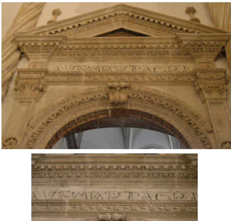
Fig. 8. Arco de acceso, entablamento y frontón de la capilla del abad Álvaro de la Torre. Iglesia Mayor de Baza. Foto: los autores.
