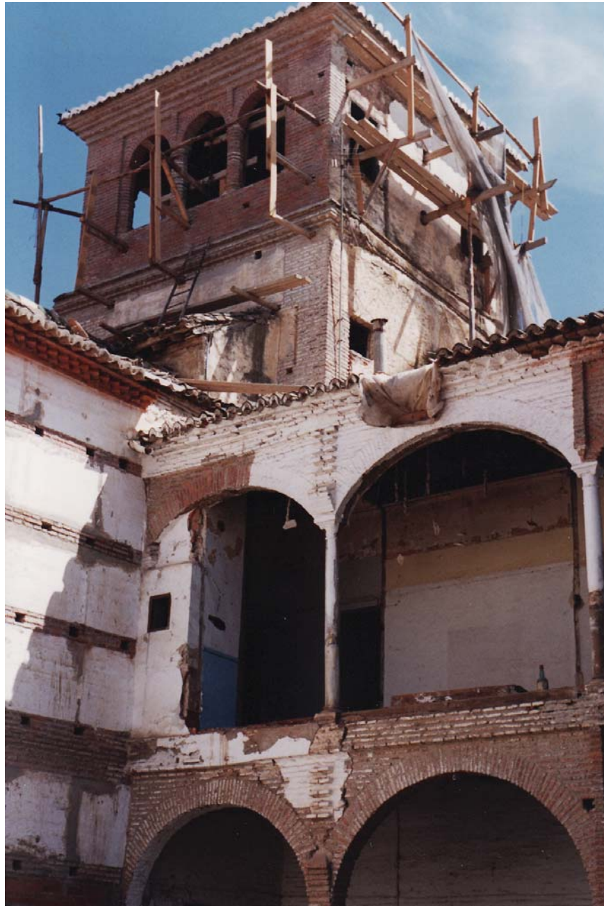
Lám. 5. Palacio de Villaalegre durante las obras de rehabilitación. Foto: Archivo Cambil Campaña.
