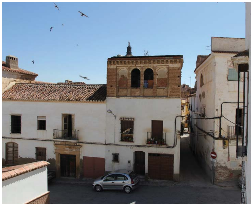
Lám. 7. Casas solariegas de la calle Duende. Foto: J.M. Gómez-Moreno.
