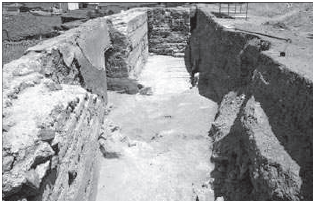
Sondeo 22.000. Vista general con la destrucción de las torres de flanqueo de la puerta medieval y muros para la alineación de las fachadas.
