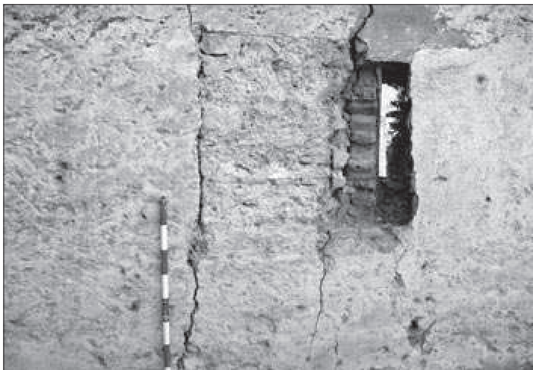
Tronera cegada del muro oriental.
