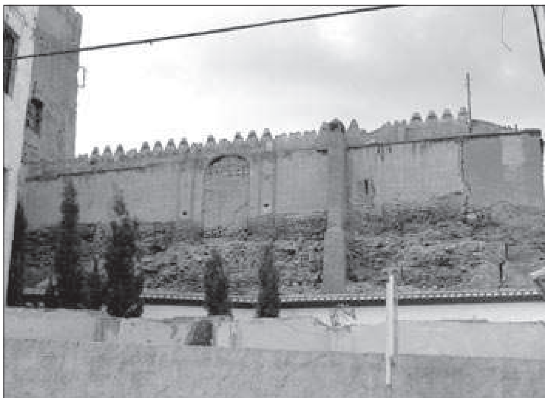
Muro oriental con la puerta de acceso al cuartel y las troneras.
